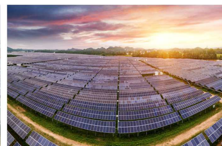
内蒙光伏电站项目
